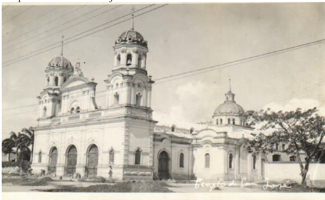
1925: Manos a la obra para refaccionar el templo de San José y construir la residencia de los Misioneros
