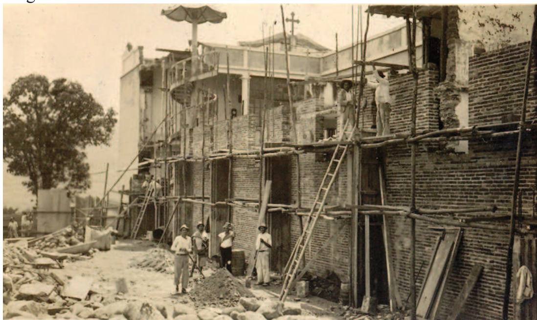
Construcción de la nueva residencia: obsérvese la famosa escalera de caracol a la izquierda
